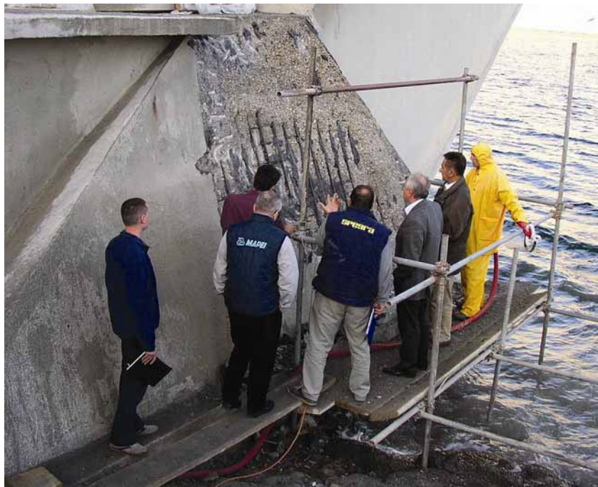
Pregled probnog polja sanacije
